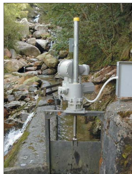
Ilustracja 1. Armatura z napędem SI-POS na jazyze odcinającym
