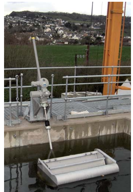
Bild 3: Kompakte Bauweise – nicht nur für diesen kleinen Dekanter
