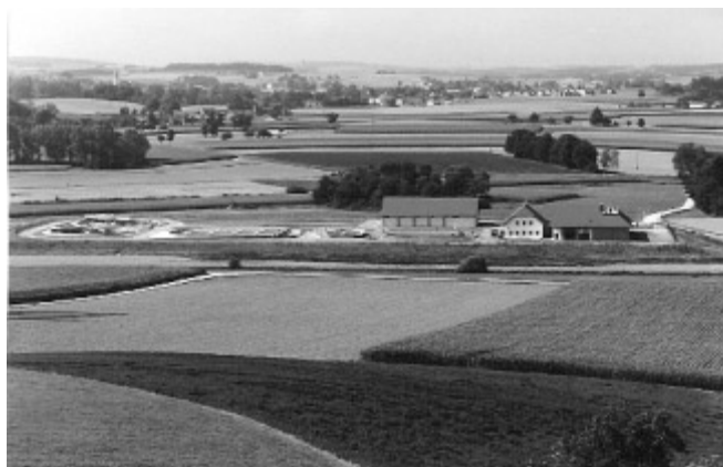
Bild 1. Kläranlage Aschachtal – bauliche harmonische Einbindung in landwirtschaftlich strukturierte Umgebung.
