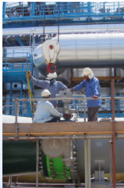
Montage unter „erschweren“ Bedingungen
