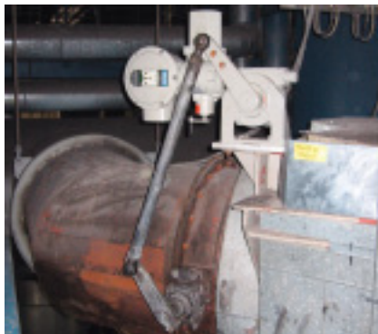
Neuer Antrieb auf vorhandener Armatur
