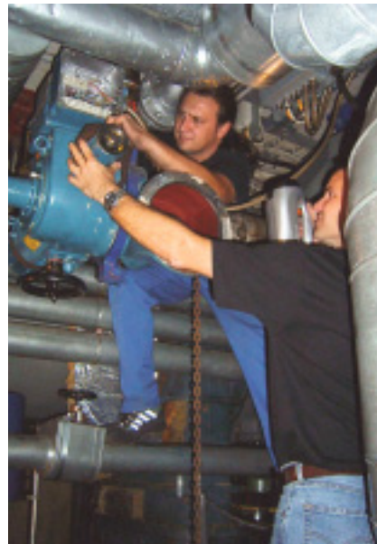
Reparatur in jeder Lage
