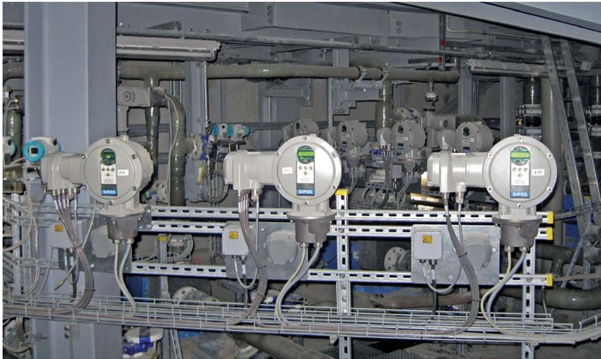
**Bild 1:** SIPOS-Stellantriebe im Kraftwerk
