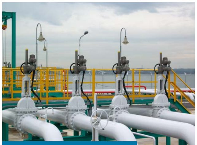
Bild 5: Explosionsgeschützte Drehantriebe SAExC im Kerosin-Verteilungs-System des Flughafens Chubu
