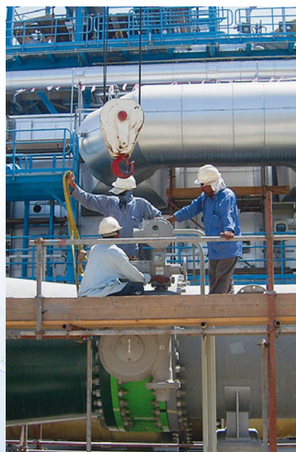
Montaż w warunkach „utrudnionych“
