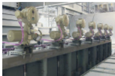
Redundant fältbusstyrning i ett stort kraftverk
