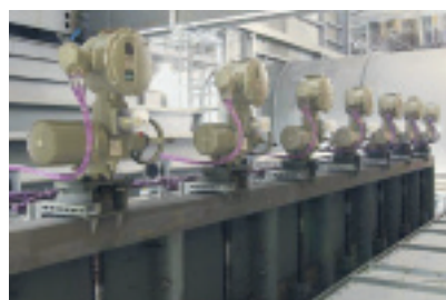
Redundancyjny układ sterowania typu „fieldbus” w dużej elektrowni.
