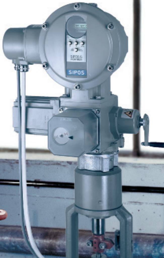
Grazie all'integrazione dell'intera elettronica di controllo e di potenza nell'attuatore, si può rinunciare ad interruttori di potenza come contattori di inversione o attuatori di inversione a tiristori - e quindi ad una larga parte dell'impianto di manovra a bassa tensione.
