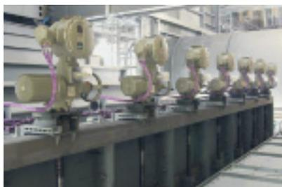
Control redundante con bus de campo en central eléctrica
