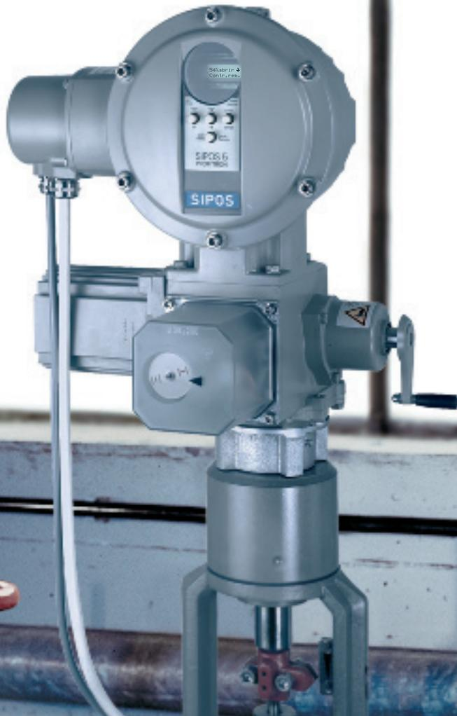
La integración de la electrónica de potencia y control en el actuador permite prescindir de aparatos como contactores inversores o inversores a tiristores, y con ello una gran parte de la instalación de distribución en baja tensión.
