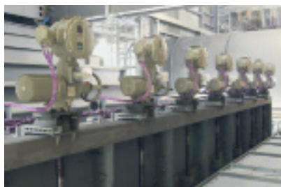
Redundantní řízení polními sběrnici ve velké elektrárně
